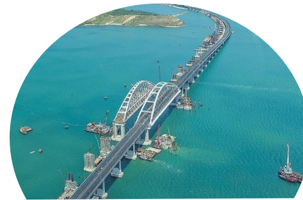
Автомобильный и железнодорожный мост через Керченский пролив
